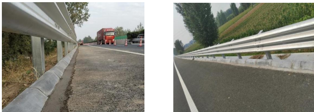
图3 HPC路缘石运行一年前后对比
